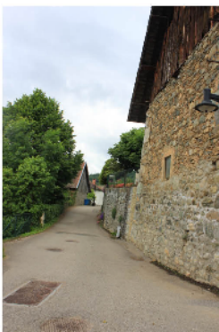
Bâtiment à l'alignement - La Bourjat.
