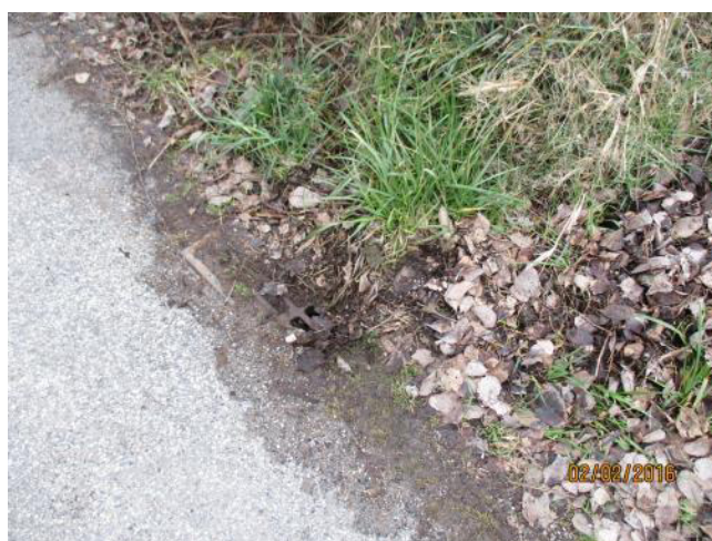
9) Grille recouverte de feuilles avec regard bouché - montée du Calapan
