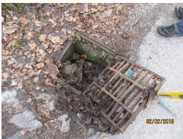
7) Grille recouverte de terre- route du Soubon
