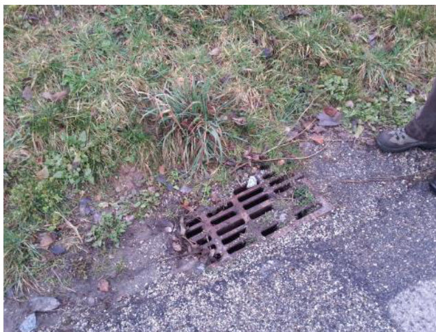
7) Grille recouverte de terre- route du Soubon
