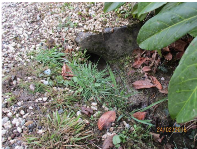
9) Grille recouverte de feuilles avec regard bouché - montée du Calapan
