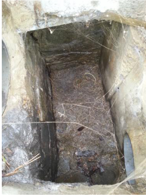
14) Grille totalement recouverte de feuilles - chemin des Magnolias, lieu-dit le Jacquet
