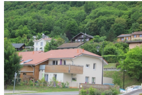
Bâtiment mixte : logements et activités libérales St-Vincent-de-Mercuze, Grésivaudan
