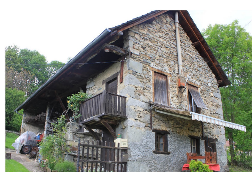
Adaptation des ouvertures à la pente - Le Soubon.
