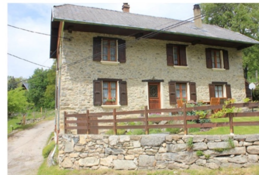
Muret en pierres, rehaussé d'une barrière bois - Le Rousset.
