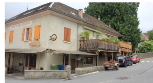
Bâti mitoyen, homogénéité des façades - Le Village.
