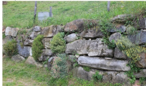
Muret de soutènement appareillé - La Bourjat.
