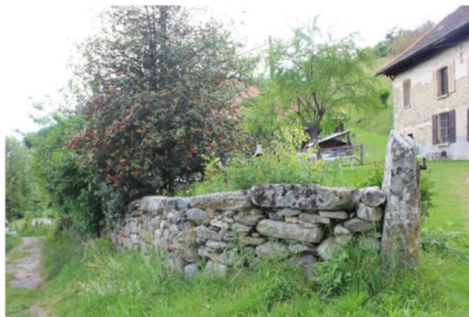
Muret en pierres - Le Soubon.
