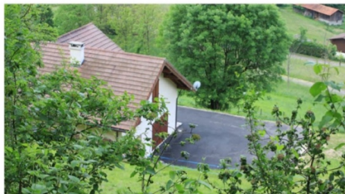
Création de plate-forme : La Bourjat.
