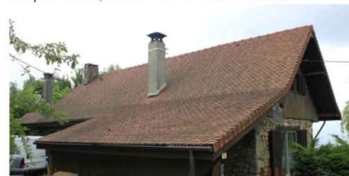
Prolongement de toiture avec rupture de pente - La Tour.
