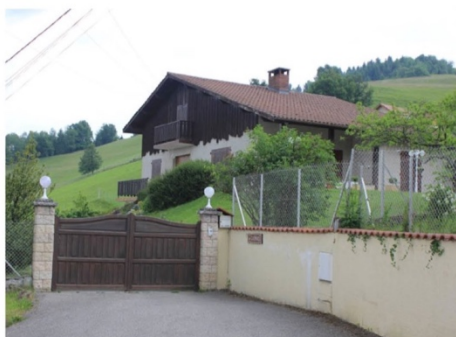
Mur et portail plein - Le Mont.
