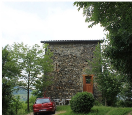
La tour, fenêtre en ogive - La Tour.
