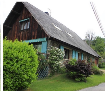
Absence de clôture - La Tour.
